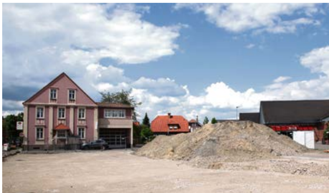
Die Bauarbeiten am neuen Gebäude neben dem REWE-Markt haben begonnen.
