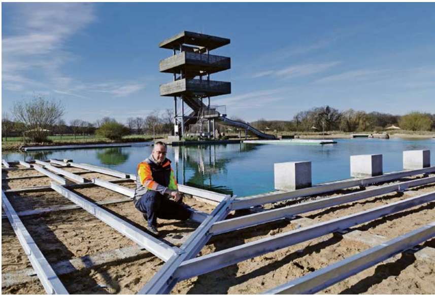
Im Naturbad werden derzeit die vier Holzdecks saniert. Dazu wird das langlebige und nachhaltige Kobony-Holz verwendet. Im Rahmen der Sanierung werden leichte Gefälle eingebaut, um Vermoosung und damit Rutschgefahr zu vermeiden. „Die Unterkonstruktion war aus Lärchenholz und wird jetzt aus verzinktem Stahl erstellt“, so der technische Leiter Markus Freck.
