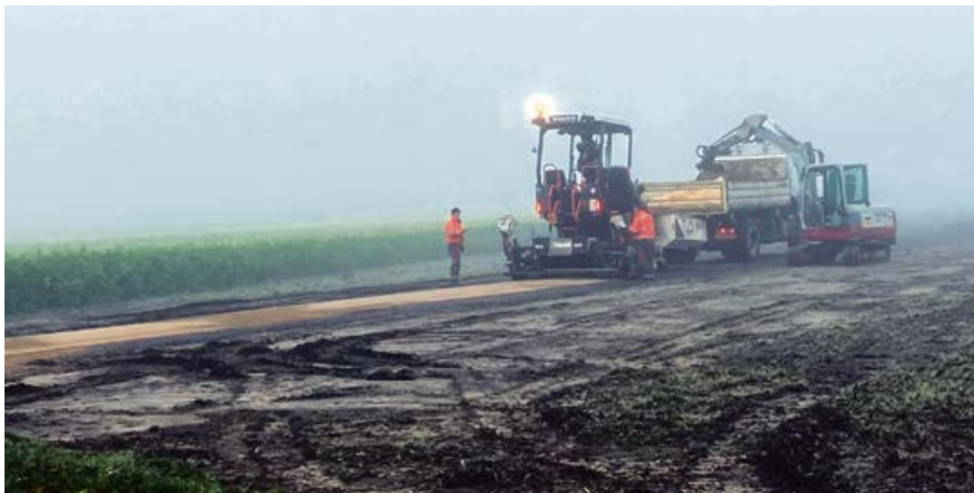
Die letzten Arbeiten am Radweg zur Durchgängigkeit von Innenstadt zum Naturparkhaus sind abgeschlossen.
