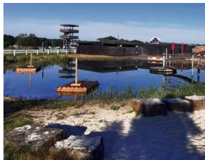
Der Wasserspielplatz wird komplett saniert.
