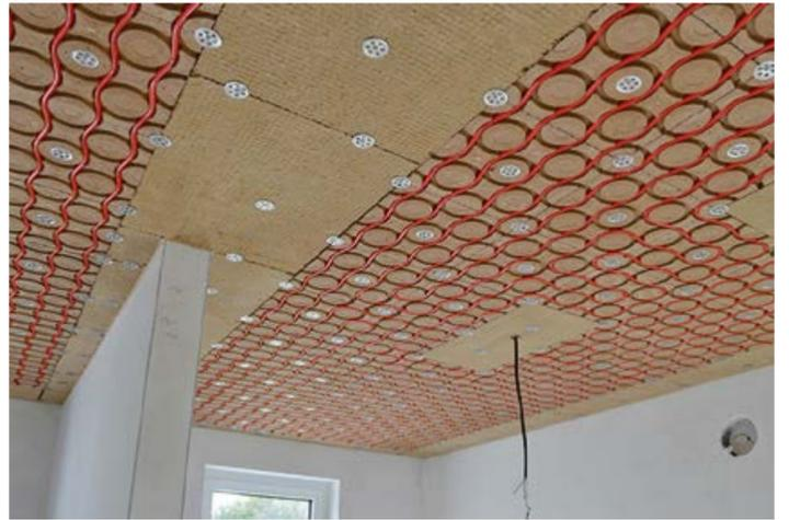
Zum Heizen und Kühlen der Räume wird in den Neubau des Rathauses ein innovatives wassergeführtes Deckensystem der Firma Argilla-Therm verbaut werden. Foto: Argilla-Therm
