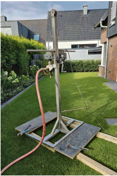
Die Bohrung für die Wasser-Wasser-Wärmepumpe ist platzsparend und die Bohrstelle nach Abschluss der Arbeiten kaum noch sichtbar.
