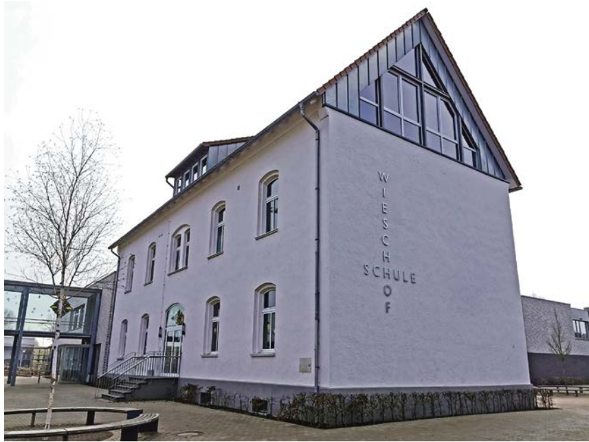
Der Gebäudeteil der Wieschhofs Schule aus dem Jahr 1920 soll nach der baulichen Erweiterung als „Haus der Betreuung“ dienen. Foto: Wiefel-Keysberg
