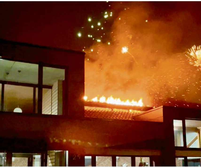
Kurz nach Mitternacht hat eine Silvesterrakete das Dach der Stadthalle in Brand gesetzt. Noch in der gleichen Nacht wurden erste Maßnahmen zur Schadensminimierung ergriffen. Foto: Feuerwehr Olfen
