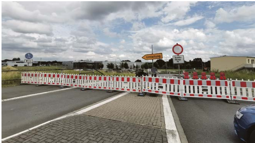
Der Endausbau im Gewerbegebiet Olfen-Ost II hat begonnen.
