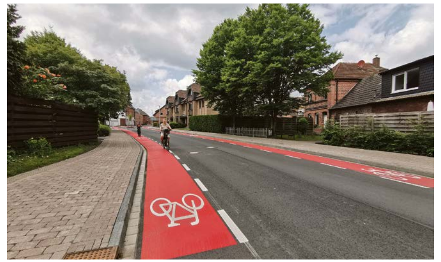
Die Baumaßnahmen zur Umgestaltung der Funnenkampstraße/Bilholtstraße sind abgeschlossen und stoßen auf positive Resonanz. Foto: Gaby Wiefel-Keysberg
