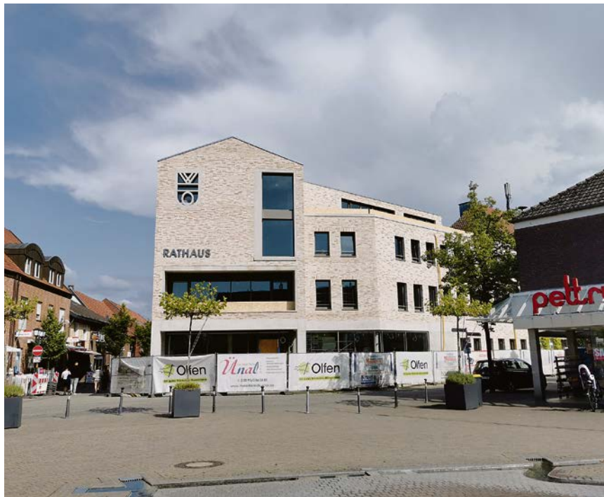
Das neue Rathaus wird die Adresse „Kirchstraße 1“ haben und damit die Hausnummer des zuvor abgerissenen Hauses „Hagen“ übernehmen.
