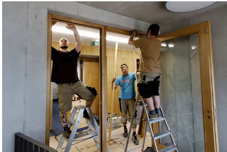
Die Handwerker verrichten noch die letzten Arbeiten bis der Umzug Mitte August in den neuen Rathauseil vollzogen werden kann. Foto: WK
