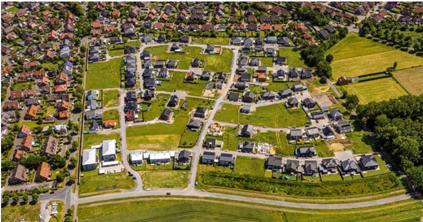
Neue Baugebiete, Unternehmen, Ladeinfrastruktur oder klimafreundliche Heizsysteme brauchen leistungsfähige Netze für eine Energiewende. Foto: www.blossey.eu
