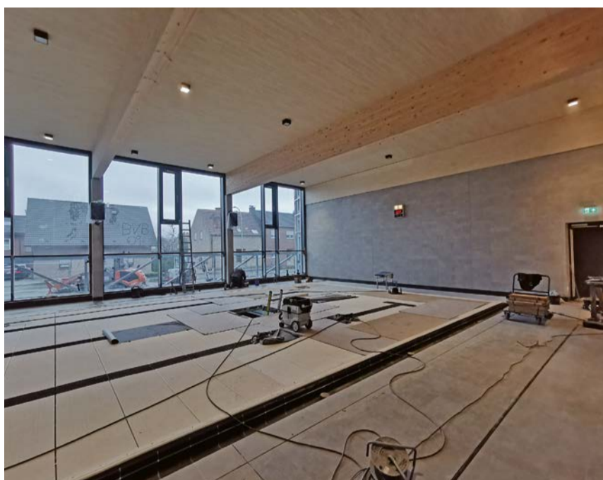
Im Hallenbad sind die Fliesenarbeiten zu 90% abgeschlossen. Der Hubboden mit integrierten Treppenstufen für ein leichtes Einsteigen ist installiert und getestet.
