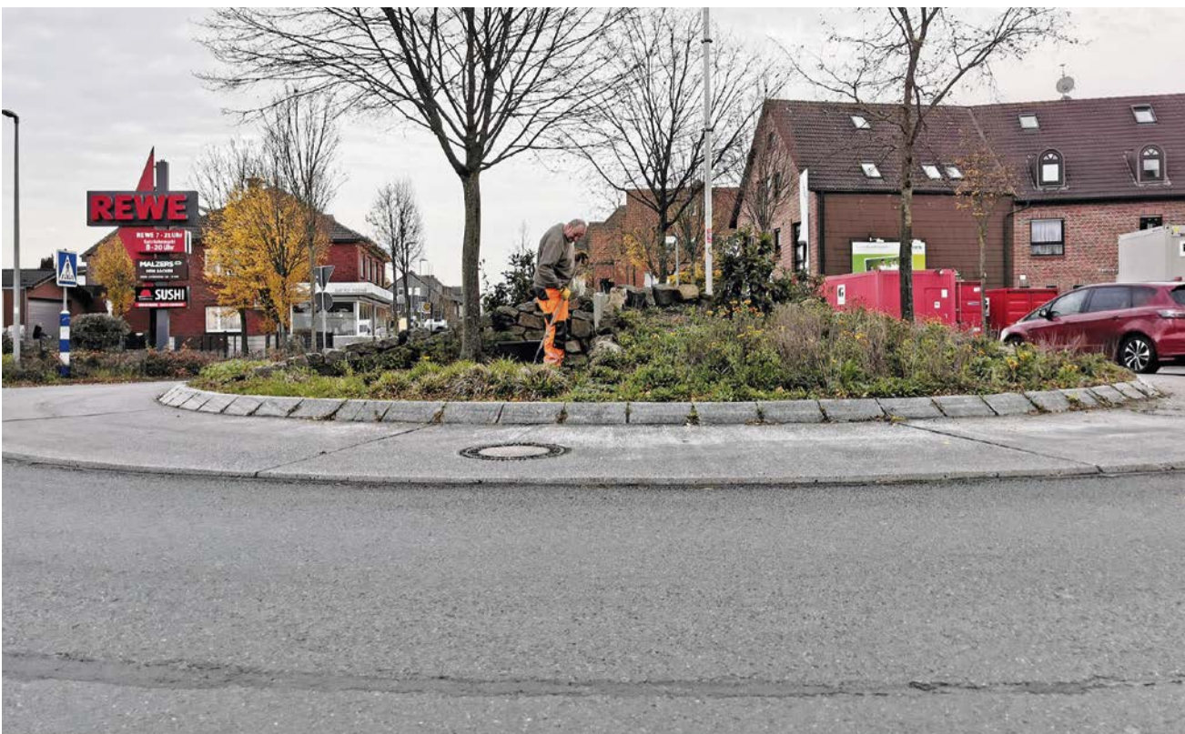
Auf dem Asphalt am Kreisverkehr REWE hat sich rundherum eine größere Fuge gebildet, die besonders Radfahrern Probleme bereitet. Die Stadt Olfen tauscht hier die Deckschicht des Asphalts aus. Dazu wird der Kreisverkehr zu gegebener Zeit für zwei Tage gesperrt. Foto: Gaby Wiefel-Keysberg
