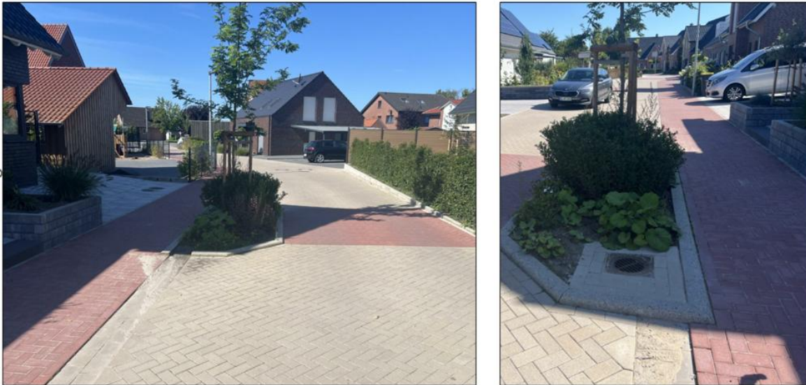
Abbildung 10: Beispiel Baumbet mit oberirdischem Zulauf und Notüberlauf
