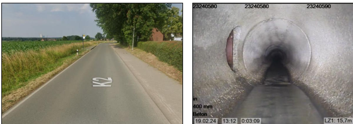
Abbildung 5: Guter bauliche Zustand Straße und Kanal
