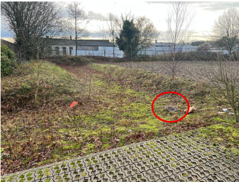
Abbildung 9: Beispiel Grünflächenmulde einschl. Notüberlauf (s. roter Kreis)
