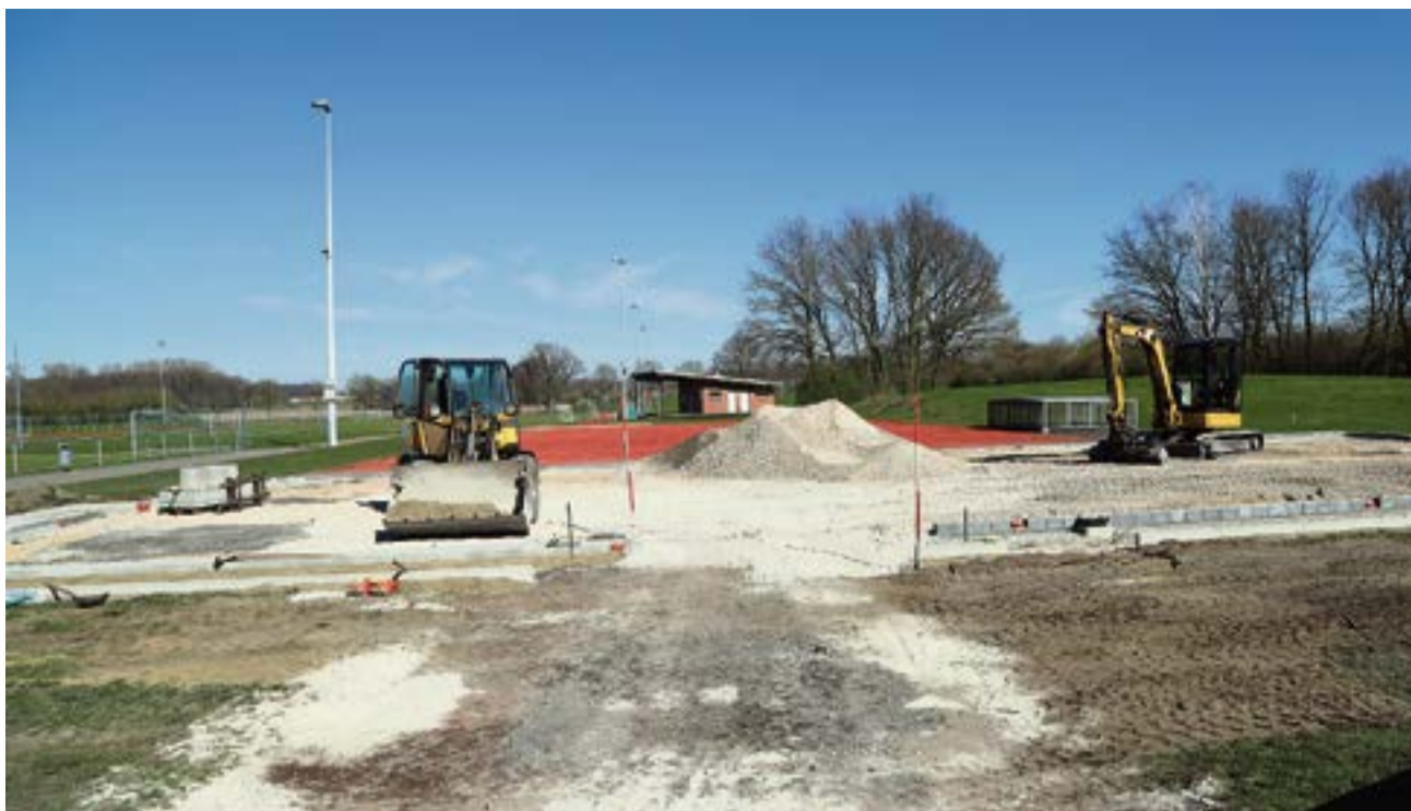
Mitte März haben die Bauarbeiten zur Erstellung des Soccerfeldes begonnen. Im Mai soll es fertiggestellt sein.
