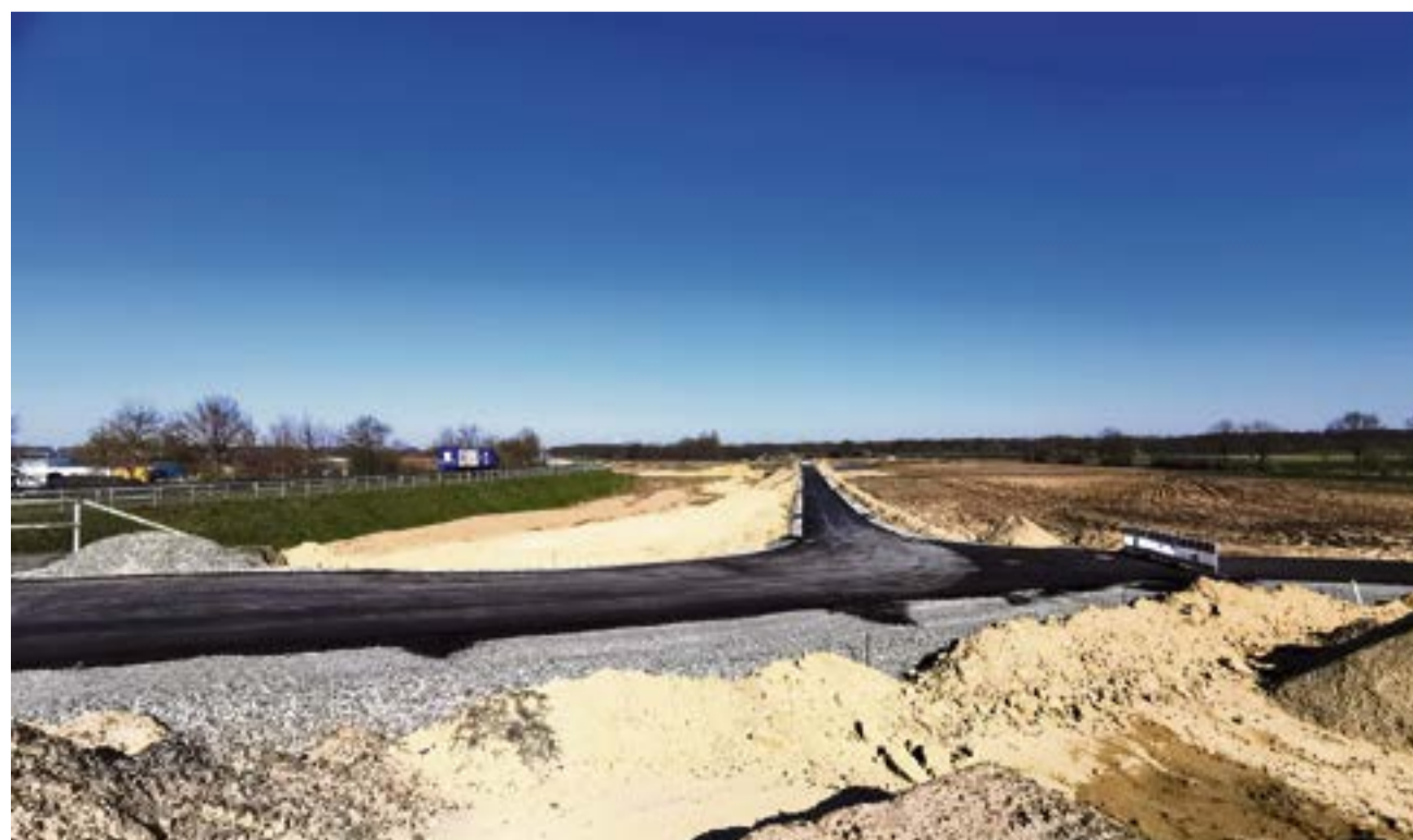
Die Erschließungsarbeiten im Gewerbegebiet Ost II sind abgeschlossen. Die ersten Baugenehmigungen sind bereits erteilt.
