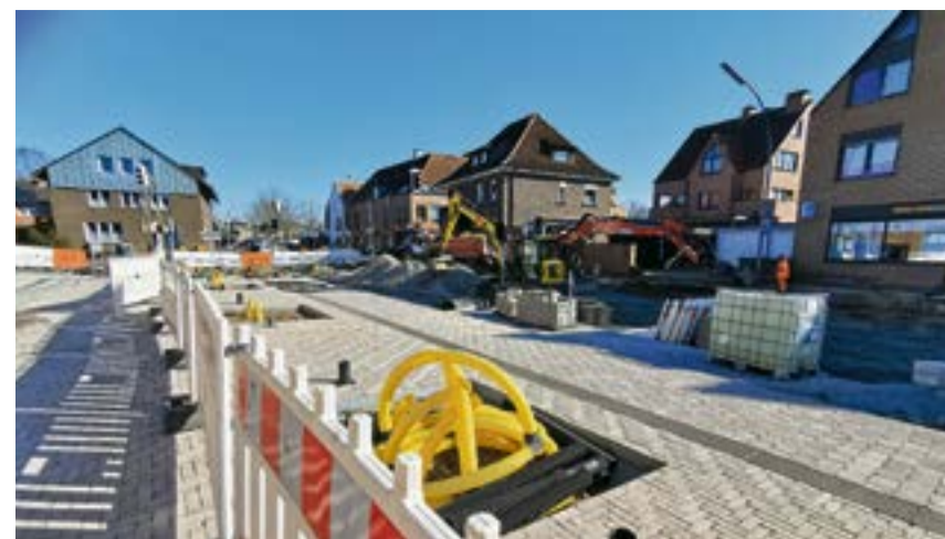
Bis Ostern soll der erste Teil der Baumaßnahme abgeschlossen sein.
