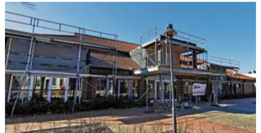
In und um die Stadthalle schreiten die Arbeiten zügig voran.
