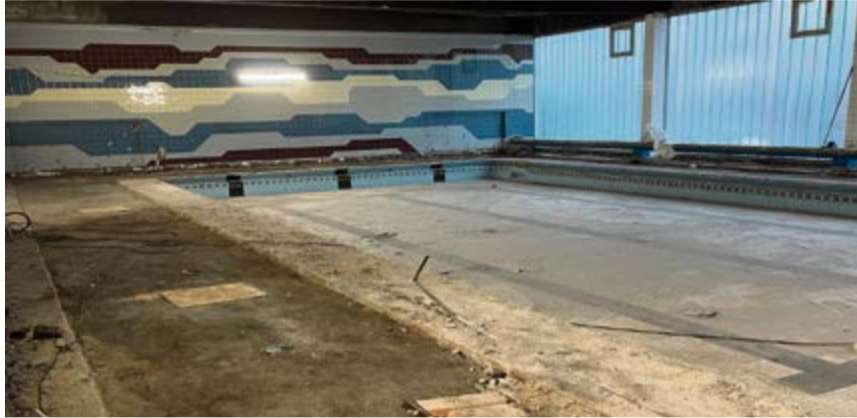
Die Rückbauarbeiten im Hallenbad haben begonnen. Weiter geht es mit der Geest-Turnhalle.
